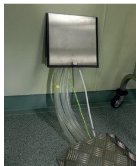
Abb. 3: Wanddurchführung, IK Bernau HZB
